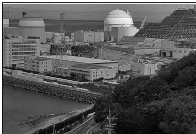
建物右側部分に乾式貯蔵設備建設中
