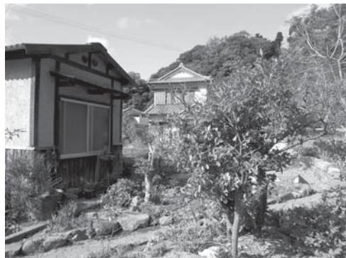
写真 25 鶴見大字有明浦鮪（しひ）浦の家屋（左の建物）外壁に塗り壁がある場合にも地上 1.3 m（床面の上 1 m）ぐらいまでは板で覆ってある。決して敷地面から直接塗り壁であるわけではない
