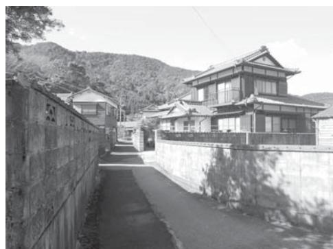
写真 24 佐伯市鶴見大字吹浦の邸宅（近代建物ではあるが日本家屋の伝統に従って建てられている）。外壁部分は大部分板で覆われ、屋根の直下の雨に直接さらされない部分だけが塗り壁になっていることに注意
