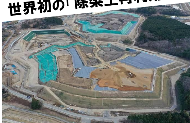
写真：環境省「中間貯蔵施設情報サイト」より
